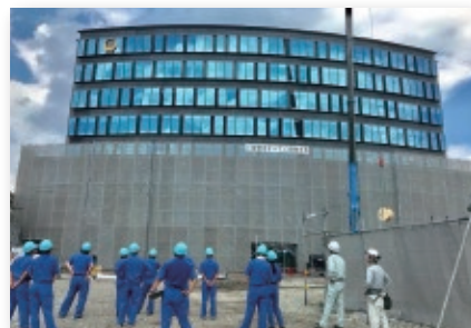
新市庁舎建設進捗状況を視察
