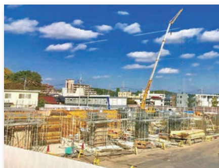
新庁舎建設、順調に進んでいます
